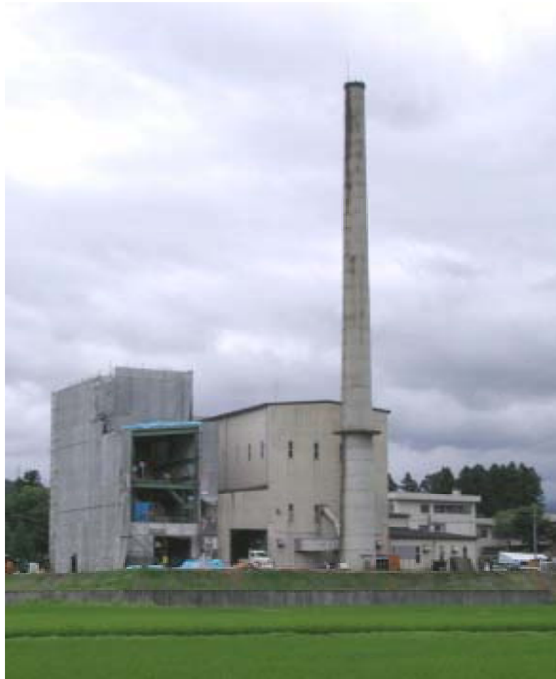
排ガス高度処理施設を建設中のクリーンセンター。周辺環境によりやさしく、地域住民が安心して暮らせる焼却炉に変わります
