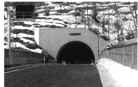
▲3月25日午後1時から通行できる栃尾トンネル(栄町側から)
