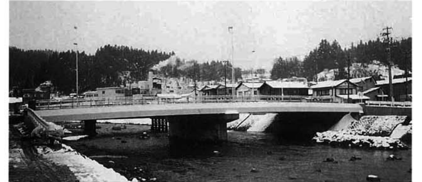
▲3月23日午後1時から通行できる松葉橋(西谷川下流から)
