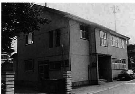
平成9年に取り壊された旧分所(栄町地内)
