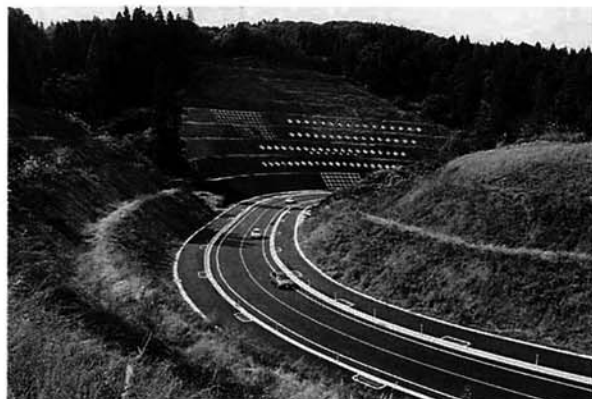
▲全面開通した道路。これまでの一車線・急勾配・急カーブが解消され、冬期間の通行が安全になる
