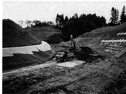
▲工事の様子。大野町地内(今年6月)
