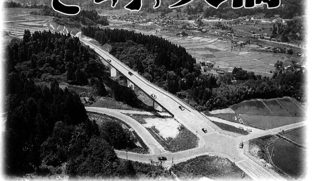
建設中のようす。(今年9月)手前は資材運搬用仮設道路。左上部(東が丘側)からワーゲンが張り出している。右側は中央の橋脚
