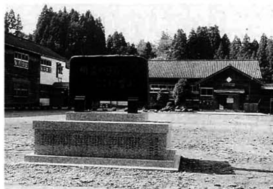
昭和28年、現在地に移転し栃尾市立塩川小学校と改称 平成10年8月の集中豪雨にも雨漏りせず耐えた頑強な校舎
