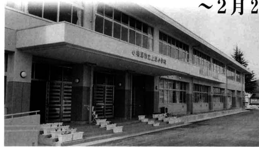
完成した上塩小学校統合校舎
