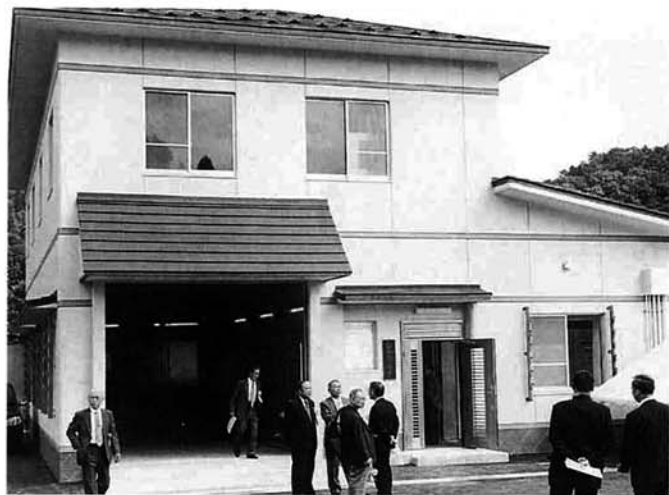
昨年10月、人面地内に完成した塩谷浄化センター（終末排水処理場施設）。これにより塩谷地区のほとんどの地域で下水道が使用可能になりました
