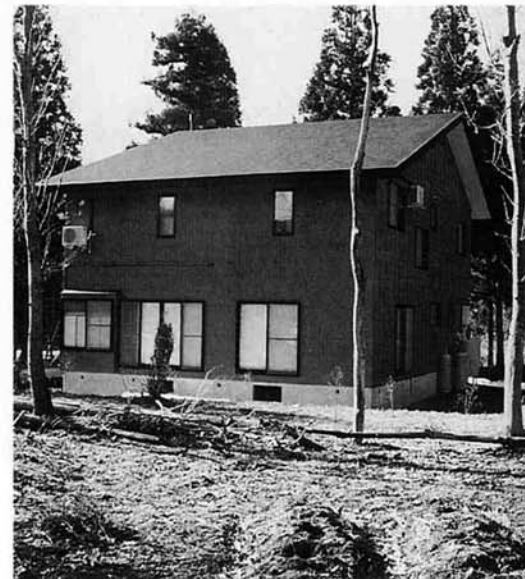
市の補助金を活用し、落雪式の屋根を使って新設した克雷住宅。雪が落下した場合のスペースが必要なため、比較的隣家と離れている住宅で施工されています
