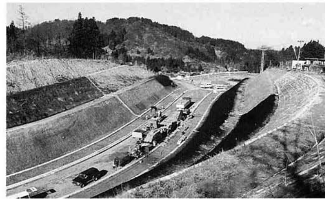
▲上の原町地内に建設中の都市計画道路環状線。今年度中に宮沢地内の国道290号と大野町地内の国道351号間が開通し、市街地の交通の円滑化が図られます
