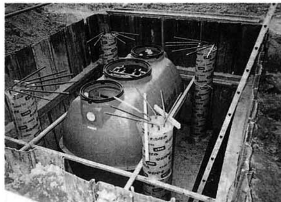
合併処理浄化槽の設置工事
