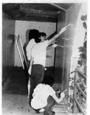
壁にかかれた落書きをきれいに塗りつぶす
