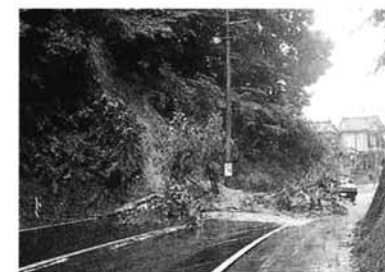
平成10年8月4日のがけ崩れ (山田町地内)
