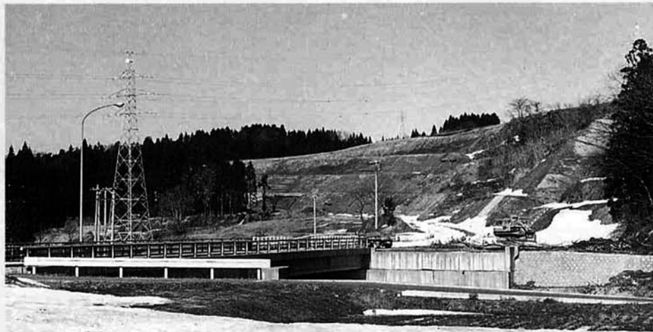
平成15年度の完成を目標に工事が進む国道290号東バイパス
