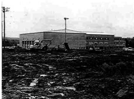
完成に向けて工が進む市民テニスコート
