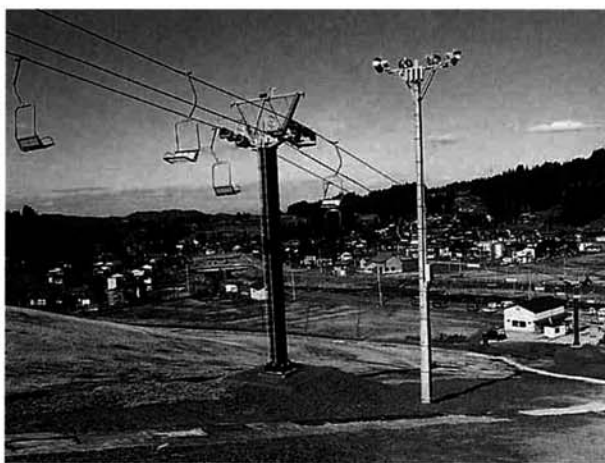
完成したペアリフトと休憩所
