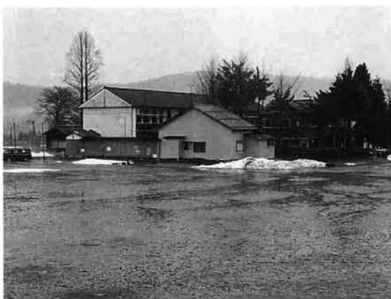
改築工事の調査・設計が計画されている上塩小学校
