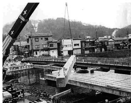
工事が進む出雲橋架け替え工事 (H9.12撮影)
