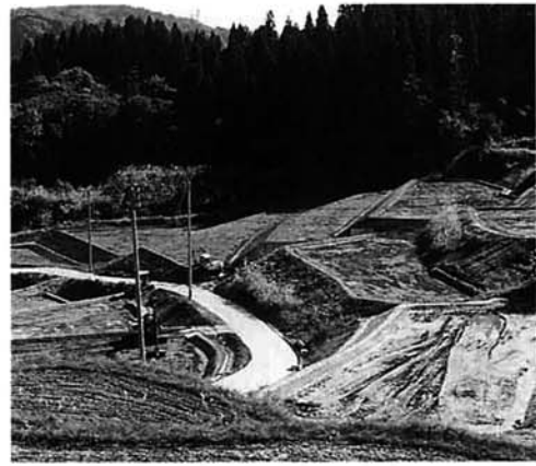
まんさく地区の基盤整備
