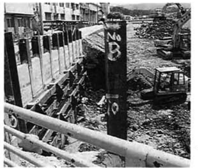
工事が進む出雲橋架け換え工事
