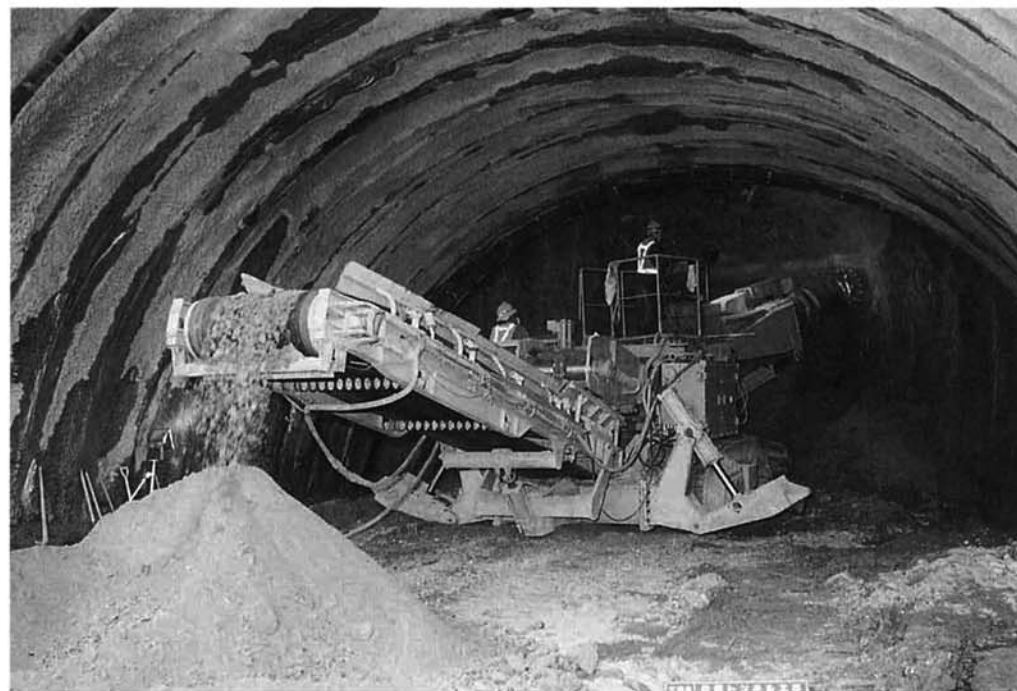
ロードヘッダ (掘削機) で1日に約1.5mずつ掘り進んでいます。
