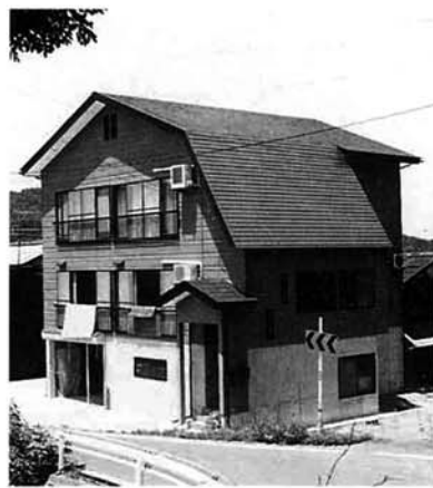
昨年、新築された落雪式の住宅（市内平地内）
