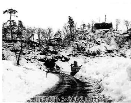
「秋葉トンネル」の起工式を来る三月十八日に行い、トンネルの掘削にいよいよ着手します。
