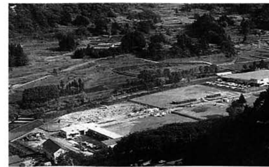
北荷頃工業団地
