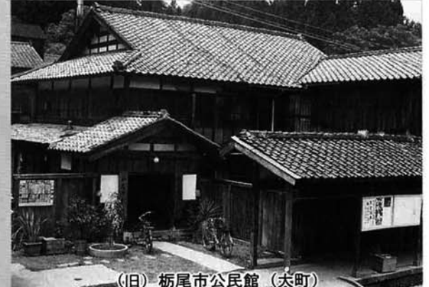
(旧) 栃尾市公民館 (大町)
