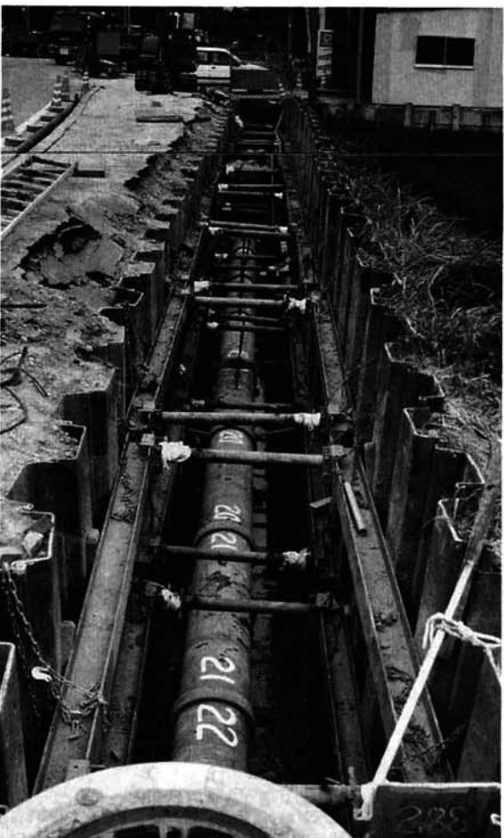
下水道工事は順調に進んでいます
