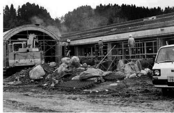
急ピッチで工事が進んでいます。
