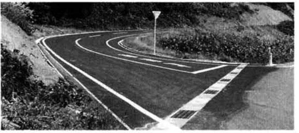
松尾集落から国道290号に接続する市道の改良工事が完成（栗山沢手前の付近）。冬の除雪も容易になります。
