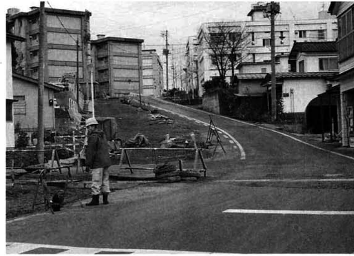
毎日多くの生徒が通学している栃尾南小～秋葉中学校の間で道路幅を約2倍に広げ、さらに歩道を整備する工事が進行中です。通学者の安全と上の原方面から市街地中心への交通が容易になります。
