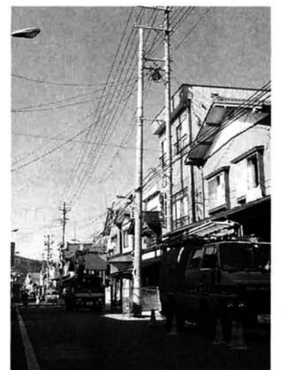
旭町～天下島で実施した流雪溝改良と道路内電柱の移転工事。立替中のこの2本の電柱の幅だけ道路が広く使えることになりました。
