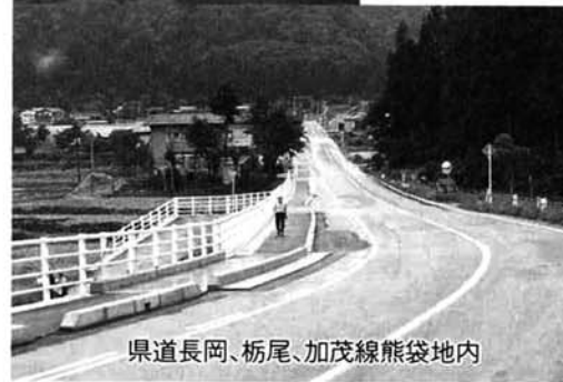
国道351号北荷頃地内
