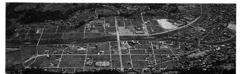
昭和53年当時の新栄町・栄町・原 町。まだ住宅はまばらであるが、原 町地内の高架橋、橋原トンネルの開 通により飛躍的に発展を遂げた。
