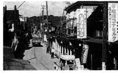
30年くらい前の谷内1丁目通り。 写真右側の建物が北越銀行栃尾支店
