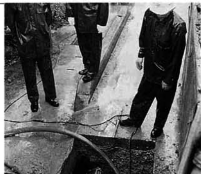
漏水修理現場、安定供給のため送水管の保守業務は大切です。
