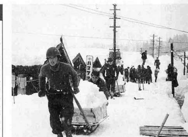
38年豪雪では自衛隊が救援に、機械力のない当時は、人海戦術による排雪しか方法がなかった
