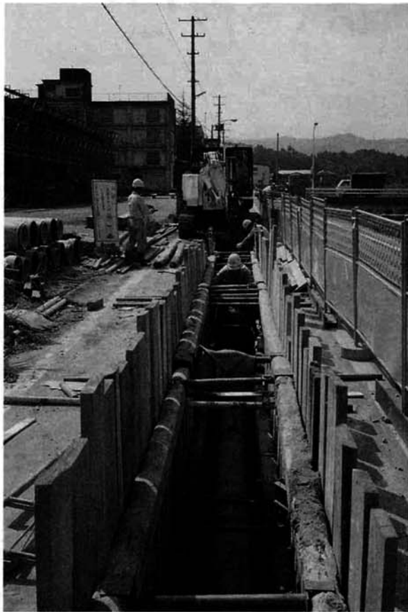
皆様のご協力により下水道工事は順調に進んでいます
