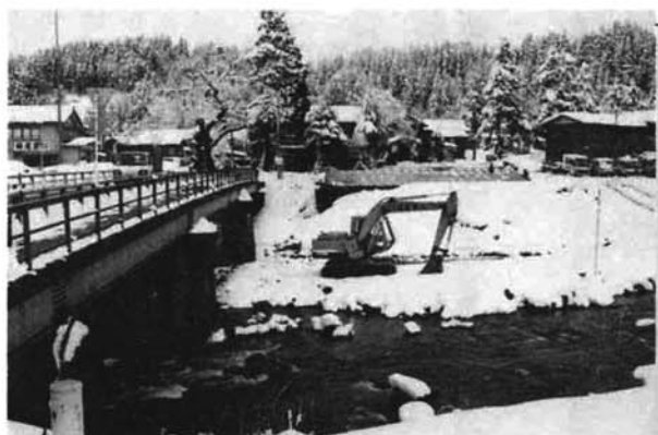
これまで狭くて車両のすれ違いも困難だった大川戸橋の架け替え工事が始まりました。現在の橋の上流に長さ53m、幅11mで平成3年度完成を目指しています。
