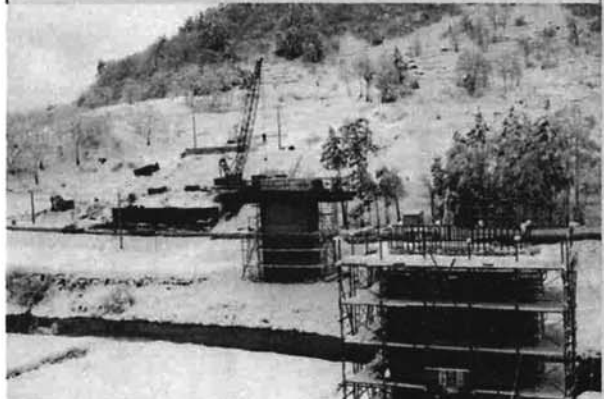
国道351号大野大橋の橋脚の姿が現れてきました。完成すると127mの長大橋となります。写真奥の斜面向こう側には平成大橋がすでに昨年末に完成済みです。
