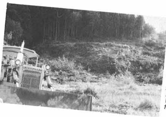
（9月18日撮影） 整地工事が着手されました
