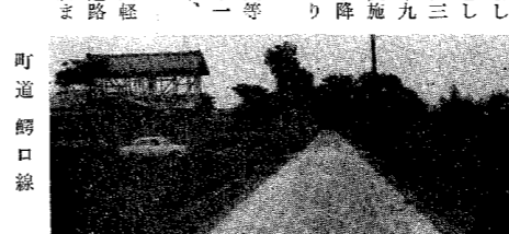
町道舗装の様子
