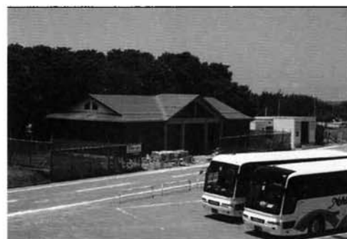
↑完成間近な公衆トイレ
