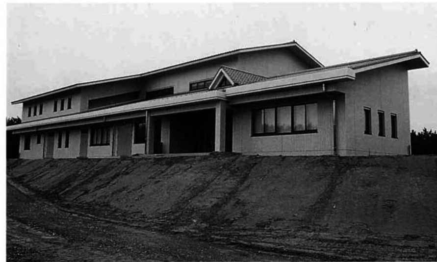
管理汚泥棟の全景
