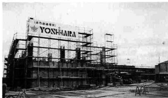
工事の進む「桐原の郷」
