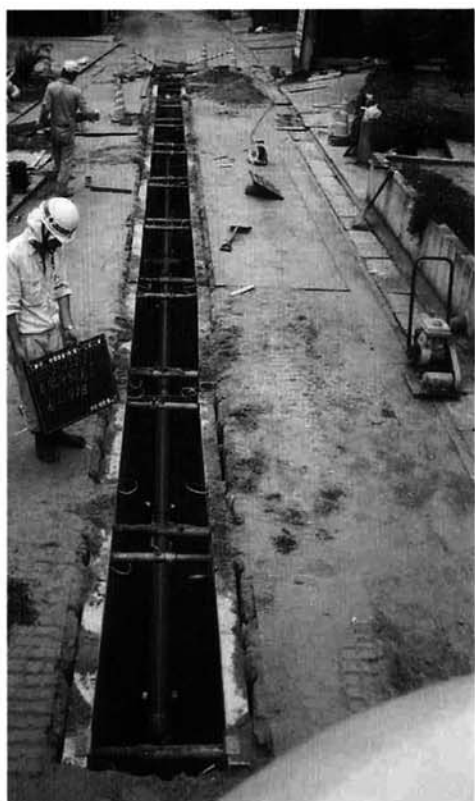
▶今年度港町地区内における開削工法による管渠の埋設状況 (下水管塩化ビニール製・内径15cm)
