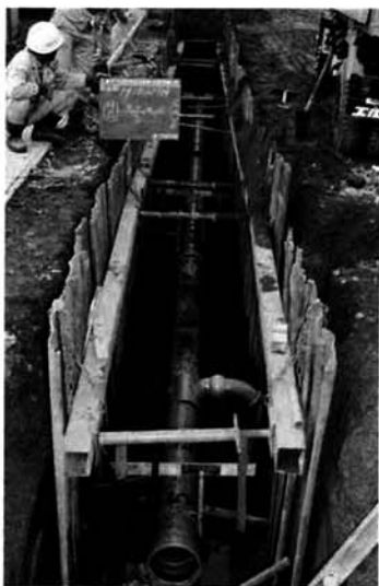
▲第1次工事(S62)の管路布設。L=871.5mが完了(全体進捗13.8%)している。
