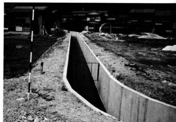
▲土水路からコンクリート水路へ。排水所要時間はぐんと短縮された。——鴨入川下流(箕輪)
