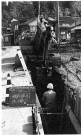
▲管路布設掘削作業
