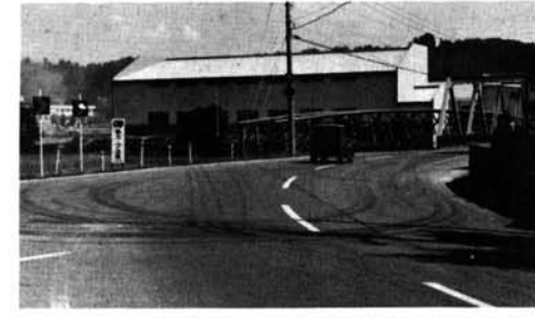
▲8/16の死亡事故現場(押切地内)
