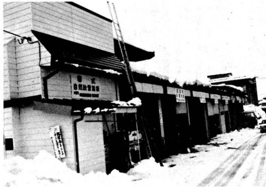
▼車庫を利用した実験棟
