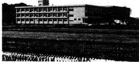
建設中の浜海小学校
