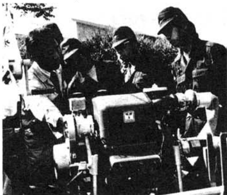
消防施設 (小型動力ポンプ)
