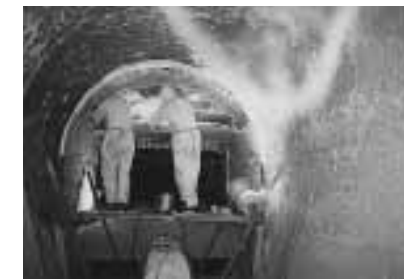
廃棄物処理施設の修理
