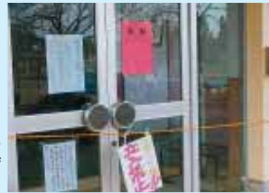
▶使用できない中学校の校舎入口
