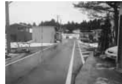
道路改良工事
