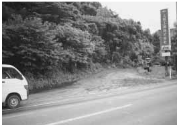
山が崩れ、道路をふさぎました (上越工業入口)
