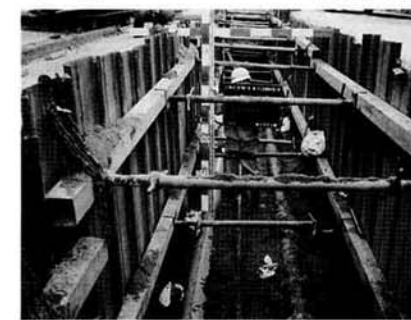
着々と整備が進む下水道
