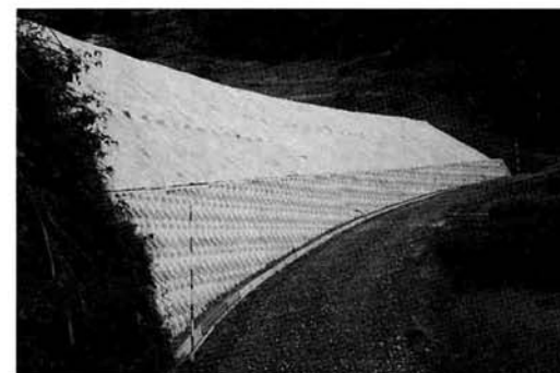
農道災害復旧事業「三桶地内」
