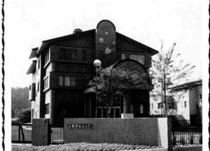
「小国浄化センター」
