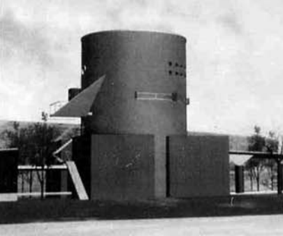
▲完成間近オプスタワー
