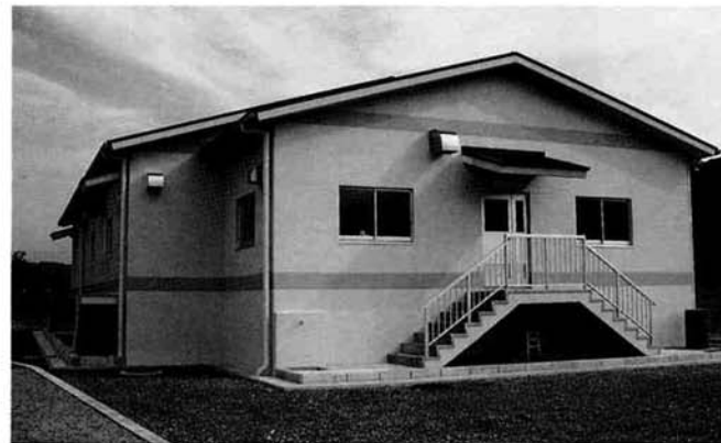
▲ 原森山地区排水処理場
