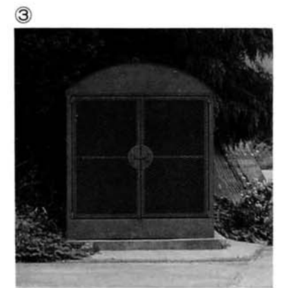
ごみ格納施設
