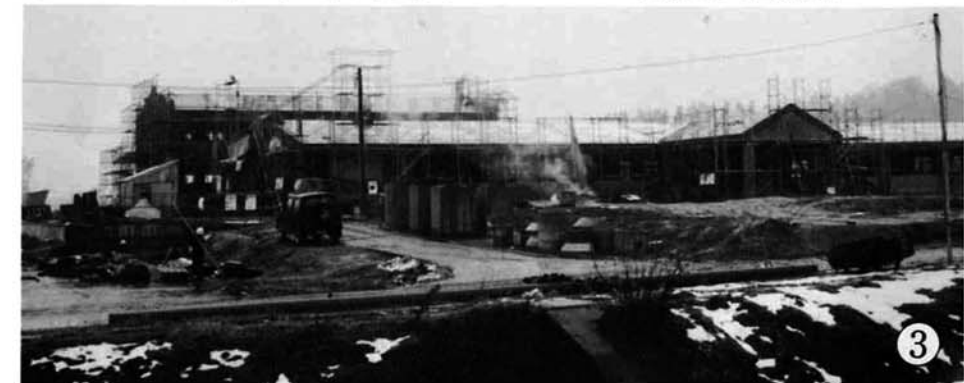
▼建設進む町立診療所
