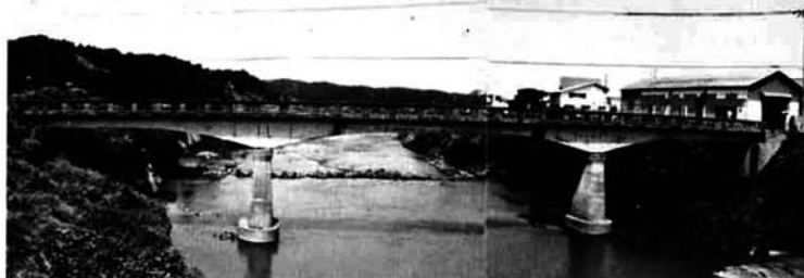
現在取り壊わされてしまったが、当時907万円を投じた中曽根橋
