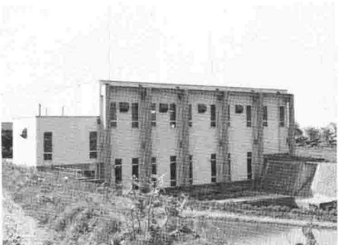
▲大沼排水機場
