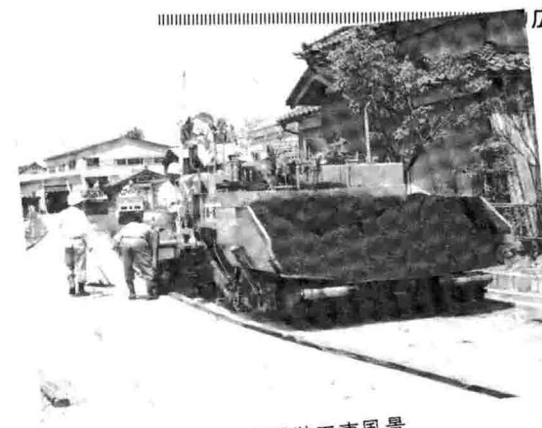
▲町道舗装工事風景
