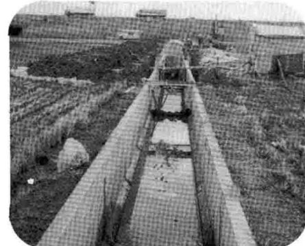
▲工事中の第2都市下水路
