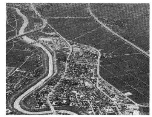
上空から見た中之島本村とインター付近
