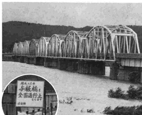
▲与板橋全面通行止
