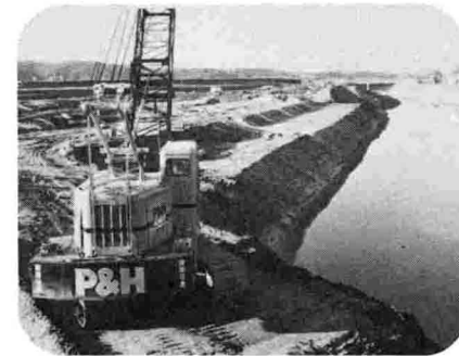
猿橋川改修の様子(中条地区)
